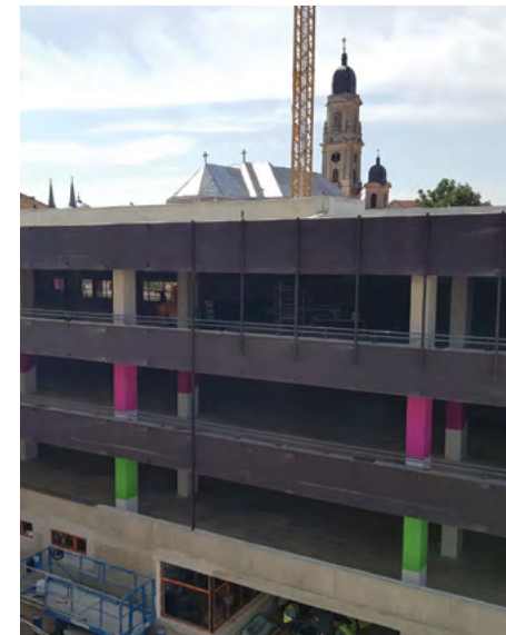
PARCAREA BRAȘOVULUI ( în lucru - 395 LOCURI )
