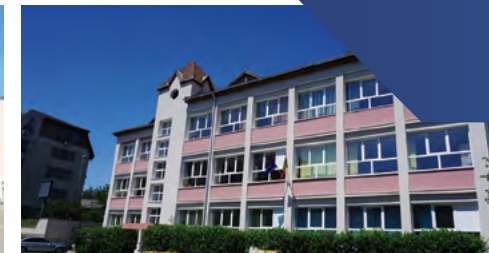
REABILITARE TERMICĂ ȘCOALA DACIA (în lucru)
